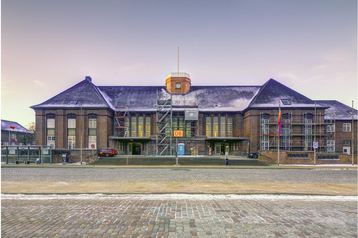
Bahnhof mit neu verkleidetem Uhrenturm vom Bahnhofsvorplatz
