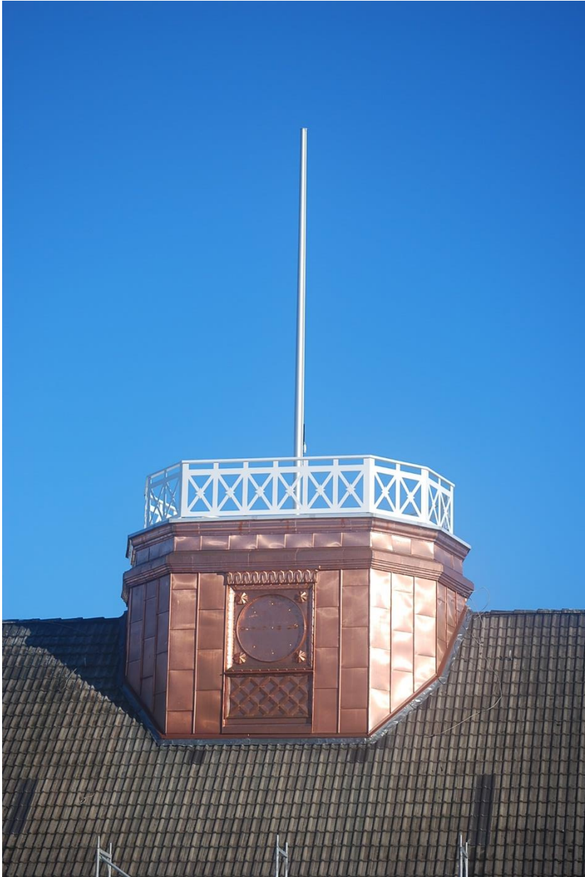
Uhrenturm von der Gleisseite
