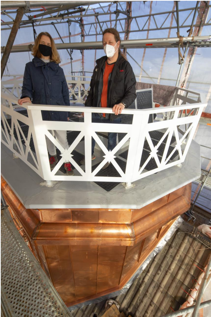
Kirsten Bester, untere Denkmalschutzbehörde der Stadt Flensburg und Matthias Rust, Dachdeckerei Rust auf dem Dach des Uhrenturms des Bahnhofs
