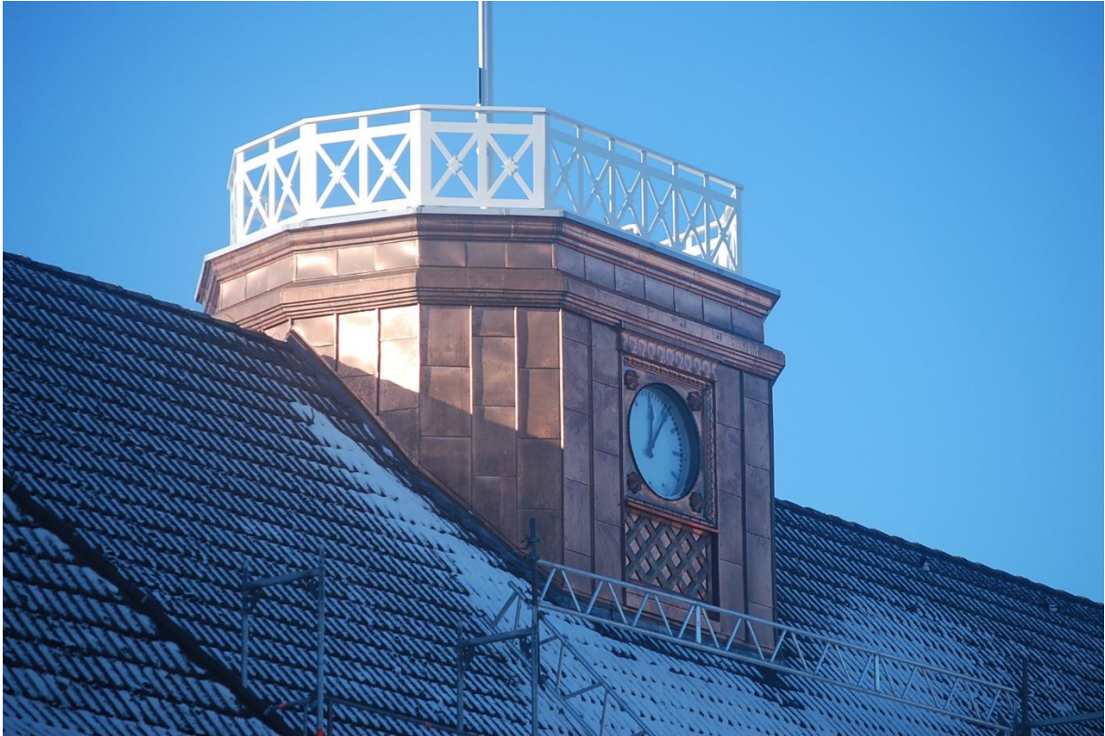
Sanierter Uhrenturm von der Stadtseite des Bahnhofs
